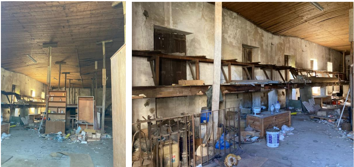
Figura 17 - Interior do espaço antigo lagar
