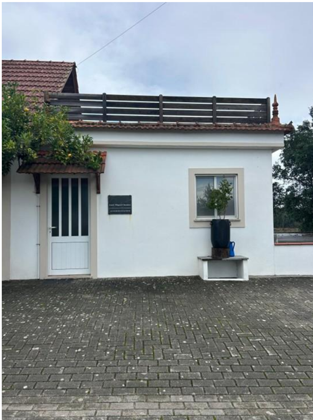
Figura 12- Imagem da fachada principal do edifício. (Fonte: Autora. 2025)
