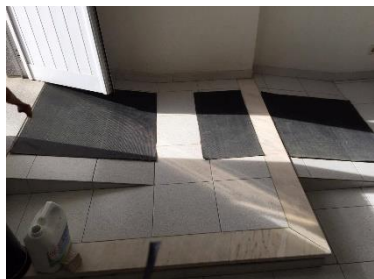
Figura 2 -Entrada existente do espaço
