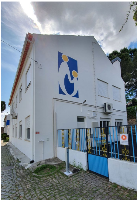
Figura 23 - Símbolo na lateral do edifício, Jardim de Infância Dr. Alfredo da Mota. (Fonte: Do Autor).
