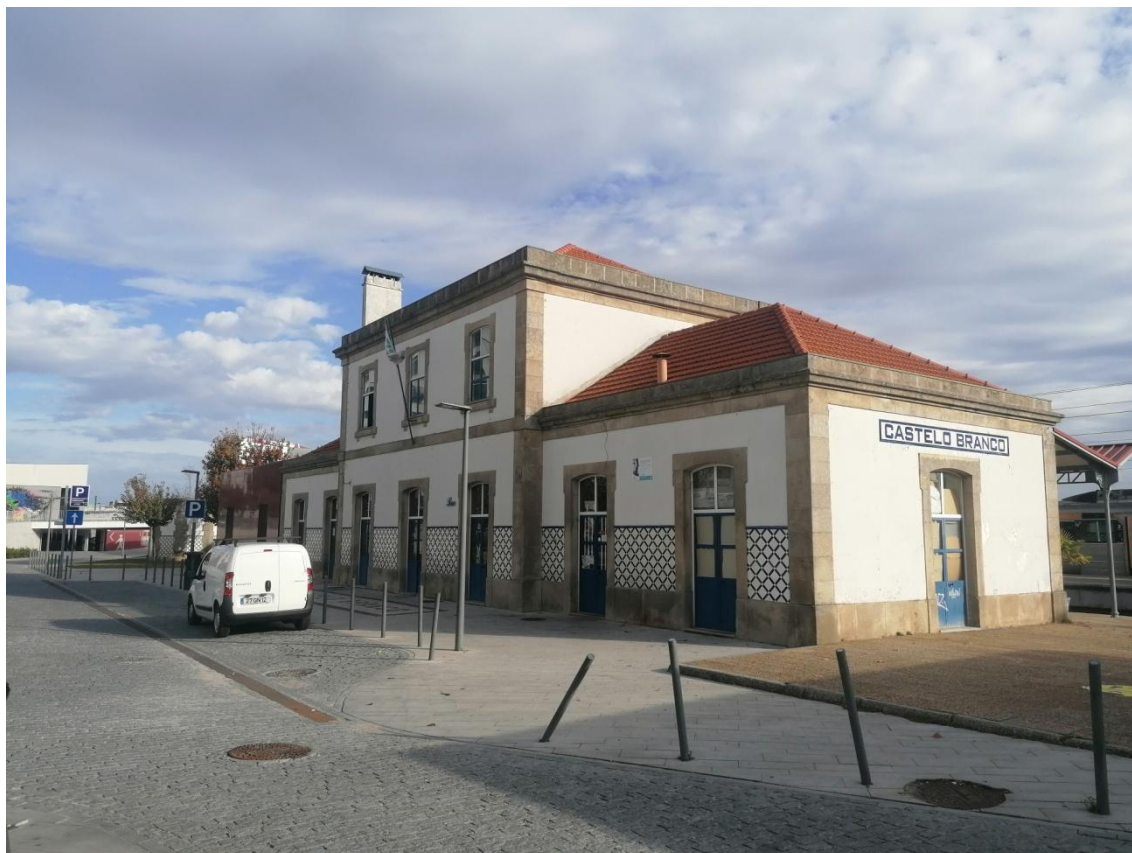
Figura 1-Estação Ferroviária de Castelo Branco
