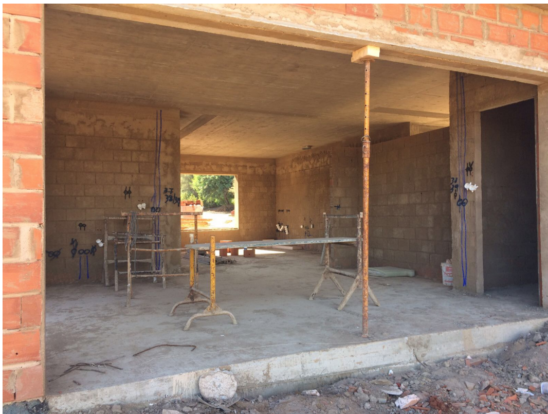
Fig. 34- Cozinha e zona de refeições.
