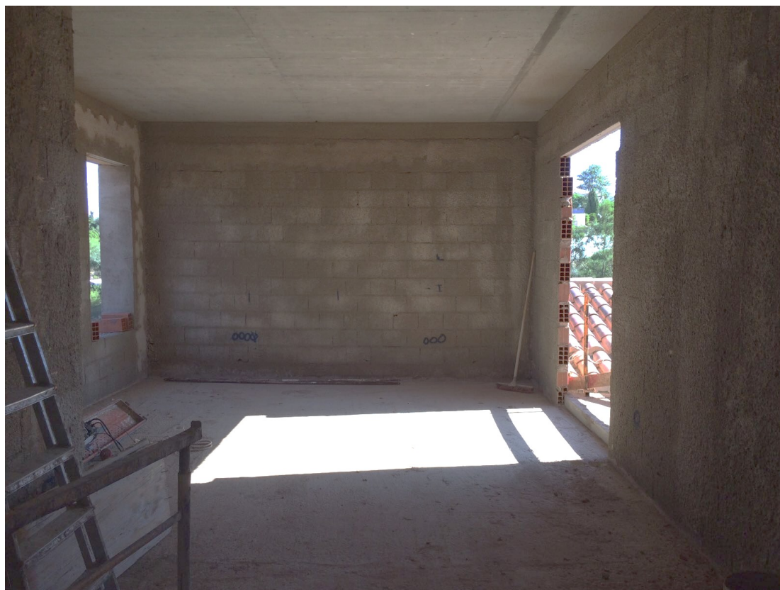
Fig. 39 - Quarto do Primeiro Piso.
