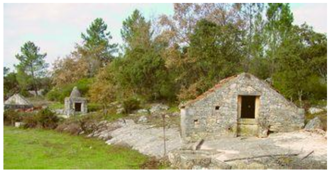
Figura 55 - Casas cisterna, Casalinho Farto. Autor: Geocaching.
