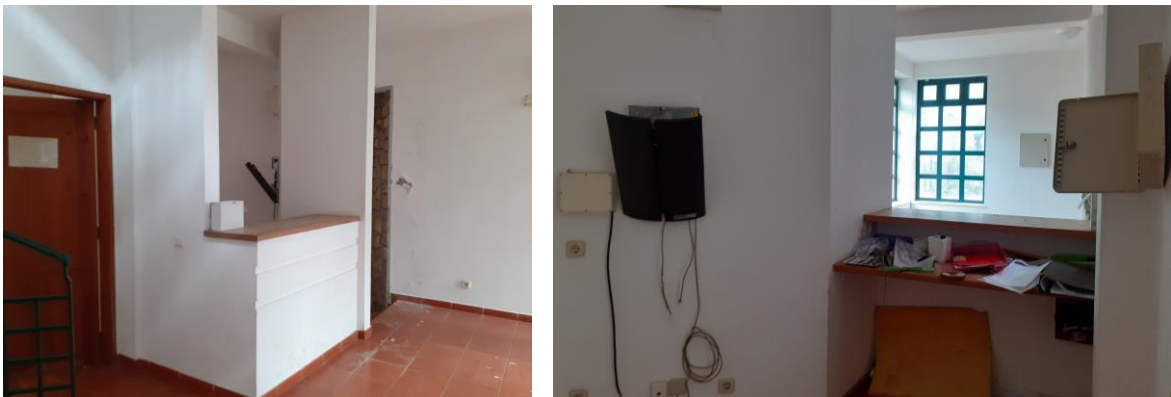
Figura 28 e 29 - Recepção. A recepção, assim como o resto do espaço encontra-se vandalizada. Neste espaço estavam as caixas de eletricidade, internet, e outras coisas que foram levadas e até estragadas. Podemos ver diversos fios pendurados e uma grande sujeira no balcão. Este espaço não é ideal pois poderia ter ambas as paredes laterais ao mesmo nível para uma visão mais alargada. Fonte: Autor
