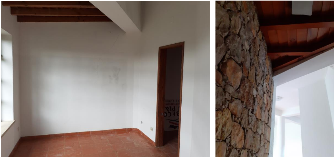
Figura 30 e 31 - Detalhes. Nestas fotos podemos ver alguns dos detalhes construtivos do edifício. Em ambas as fotos conseguimos ver a junção entre a torre com as suas vigas brancas de sustentação e a união com os tetos de madeira e paredes de pedra. Fonte: Autor.
