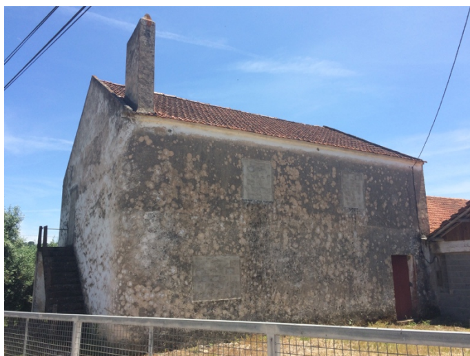
Figura 2 – Edifício Principal do Projeto
