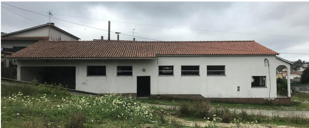
Imagem 15- Fachada lateral Esquerda
