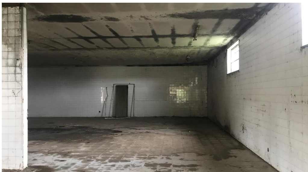
Imagem 17- Vista da parte de trás do interior do edifício
