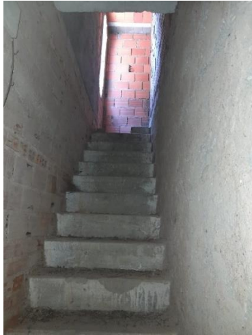
Figura 27. Escada de Acesso ao Primeiro Piso
