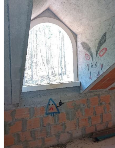
Figura 29. Janela do Piso 1
