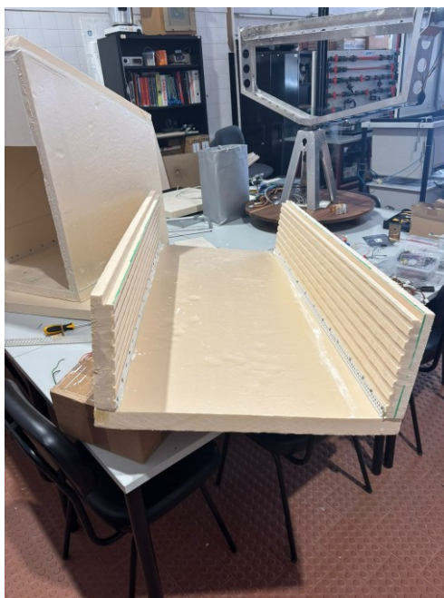
Figura 32: Estrutura do coletor solar em construção.
