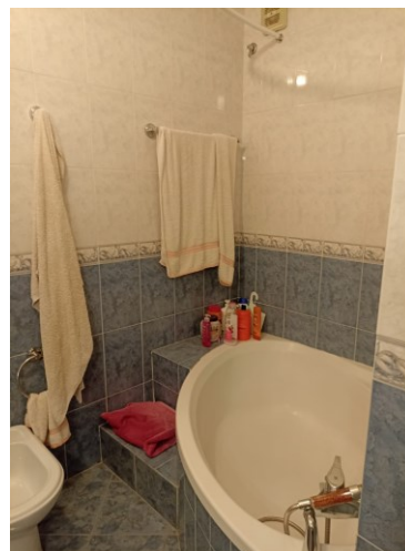
Figura 17: Instalações sanitárias, Autor: André Bastos, 10\11\2022
