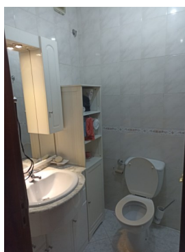
Figura 67: Instalações sanitárias, Autor: André Bastos, 10\11\2022
