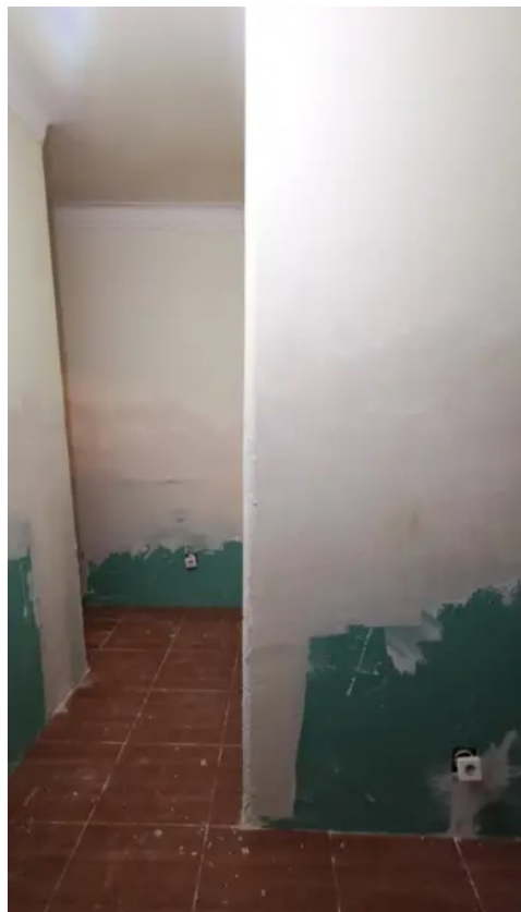
Figura 72: Alisamento e nivelamento de parede, Fonte: Homify, consultado a 14 /03 2023
