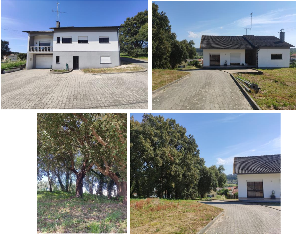
Figura 5 – Fotografia do exterior e espaço envolvente. Fonte: Marisa Francisco.
