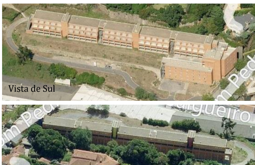
Figura 3- Vista geral do edifício (fonte: google maps)
