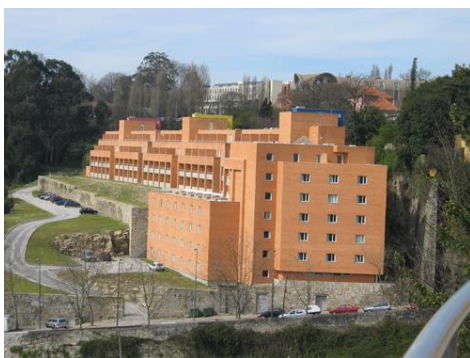
Figura 7- Fachada Sul e nascente do edifício
