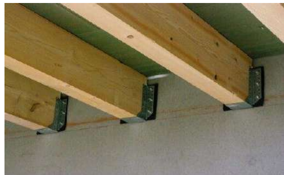
Figura 42- Solução de fixação de cama suspensa. www.pinterest.pt/pin/9007267995491198/
