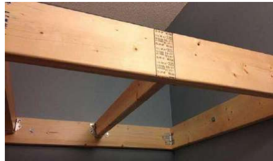
Figura 40- Solução de fixação de cama suspensa. https://imgur.com/r/DIY/IIBAU
