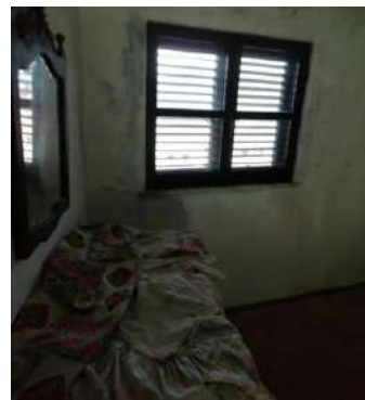
Figura 23- Quarto secundário. Fonte: Autor
