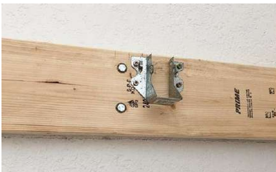
Figura 41- Solução de fixação de cama suspensa. https://www.jennasuedesign.com/diy-loft-bed/
