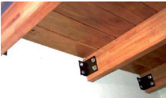
Figura 39- Solução de fixação de cama suspensa. https://www.pinterest.pt/pin/112871534407390050/
