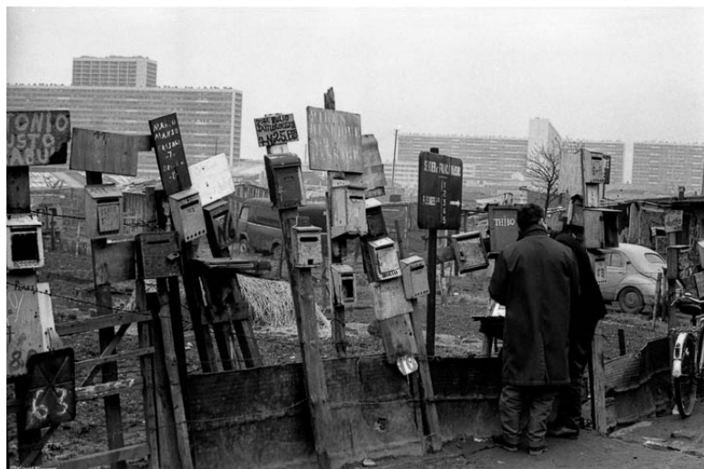
1143/20a- Les boites à lettres à l'entrée d'un bidonville portugais dans la region parisienne - Ils ont travaillé pour la plupart à la construction des immeuble que l'on aperçoit et qu'ils n'habiteront jamais. Annees 1960 ©Gerald Bloncourt
