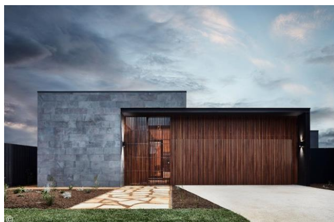
Figura 15 - Casa Pátio. Acedido a 4 de Abril de 2019 em: https://www.archdaily.com.br/br/890641/casa-patio-auhaus-architecture#
