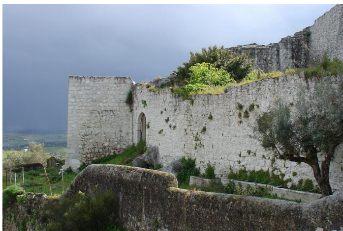
Figura 5 - Castelo do Crato. Acedido a 22 de Março de 2019 em: https://www.rotasturisticas.com/monumento_crato_castelo_do_crato.html
