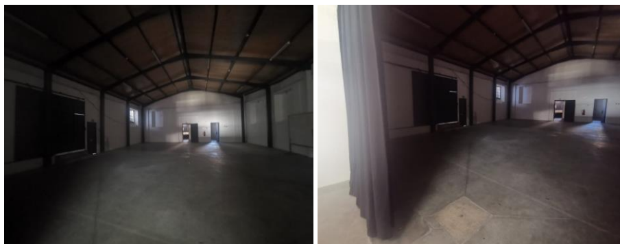
Figura 11- Segunda Nave. Fonte: Mafalda Coelho
