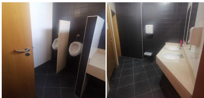
Figura 12- Instalações Sanitárias. Fonte: Mafalda Coelho
