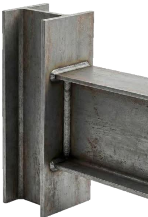
Figura 10 - Exemplo de ligação soldada
