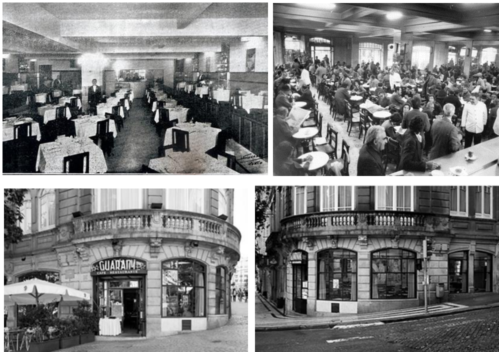
Figuras 24, 25, 26 e 27 – fachada e interior do restaurante
