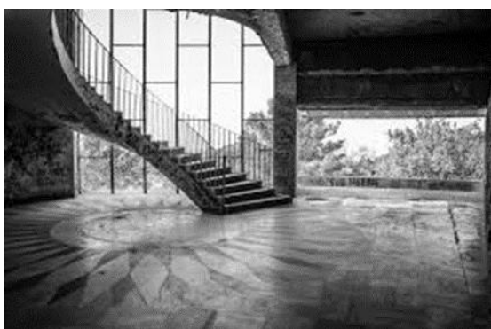
Figura 42 - interior do 1º piso escadas em espiral
