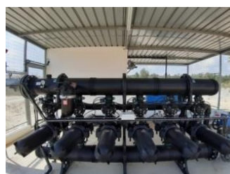
Ilustração 23 Cabeçal de filtros
