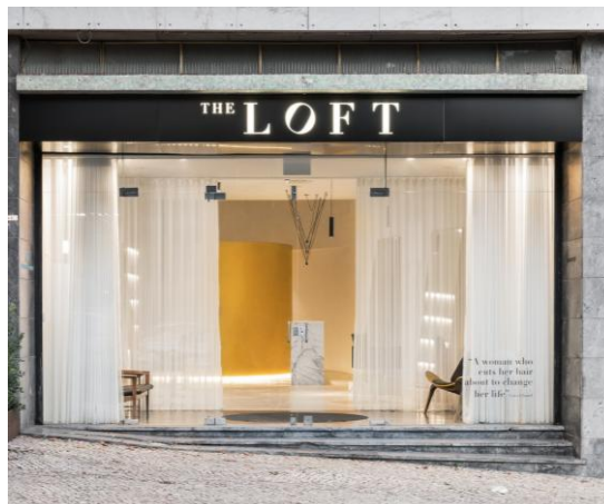
Figura 19. Fachada principal. Fonte: Pedro Vada, 2018
