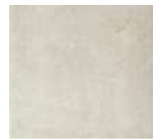
Figura 45 - Pavimento das instalações sanitárias
