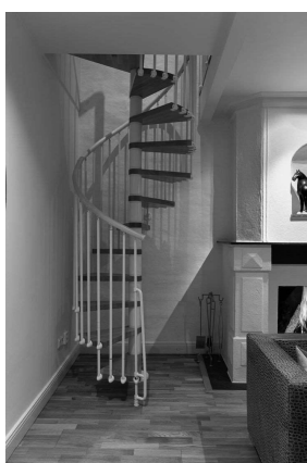
Figura 15- Escada em espiral. Fonte: Pinterest
