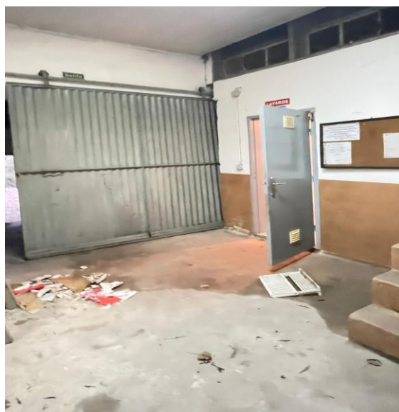
Figura 19 - Imagem do interior do espaço. (3 de novembro de 2024. Fonte: Autora)
