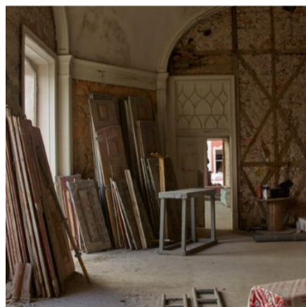
Figura 46 - Imagem do edifício em tempos de reabilitação. (s.d. Fonte: Estudio Peso)
