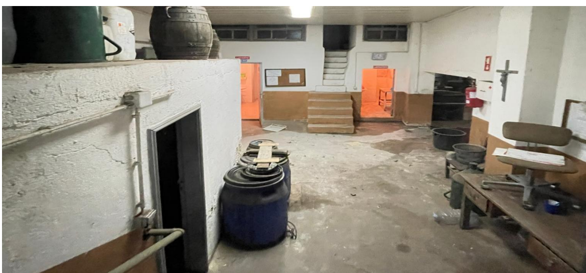
Figura 14 - Imagem do interior do espaço, direcionada para a zona de escritório e instalações sanitárias. (3 de novembro de 2024. Fonte: Autora)
