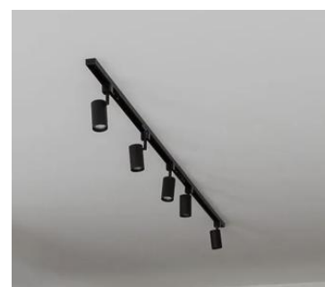
Figura 104 - Sistema de iluminação em trilho (s.d. Fonte: Lâmpada e luz)
