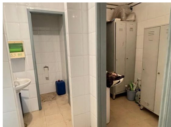
Figura 17 - Imagem do interior das instalações sanitárias. (3 de novembro de 2024. Fonte: Autora)
