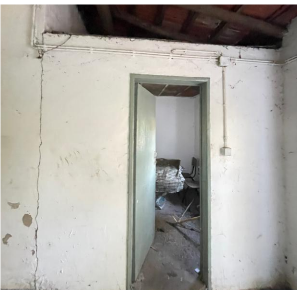
Figura 18 - Imagem do interior do espaço, direcionada para zona de arrumos. (3 de novembro de 2024. Fonte: Autora)
