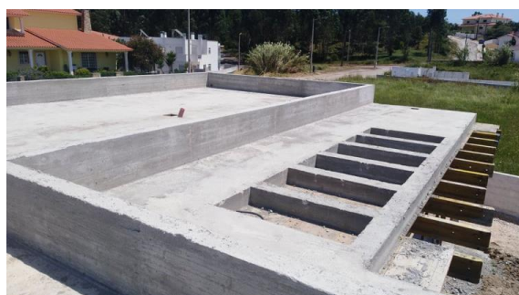
Figura 61 - Pormenores construtivos (14 de junho de 2020). Fonte: Autor.
