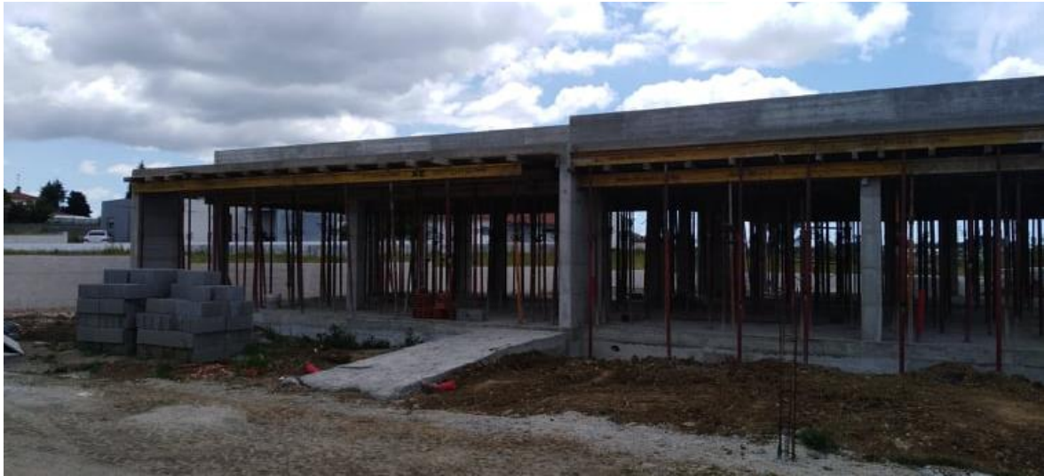
Figura 3 - Fotografia do processo de construção da moradia (14/06/2020). Fonte: Autor.
