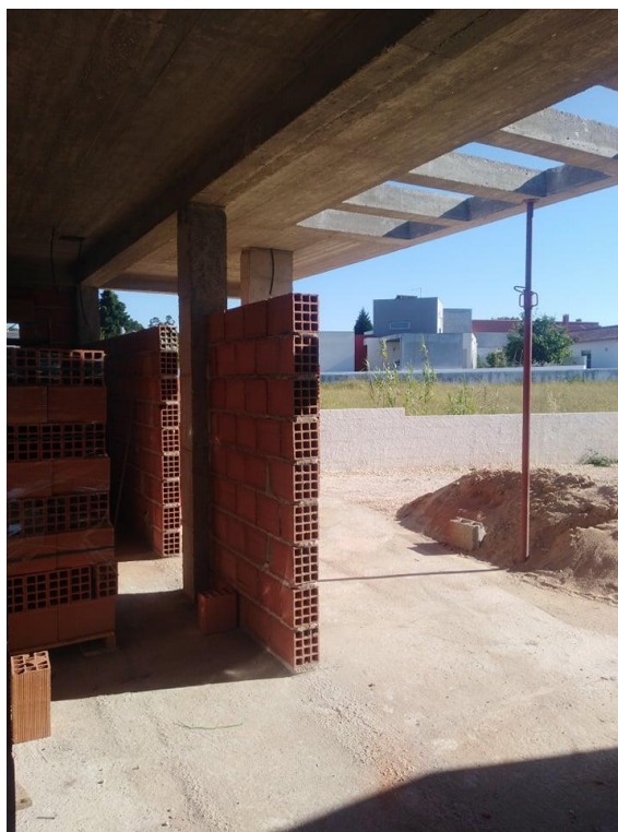
Figura 67 - Vista da zona interior correspondente à sala de estar (4 de julho de 2020). Fonte: Autor.
