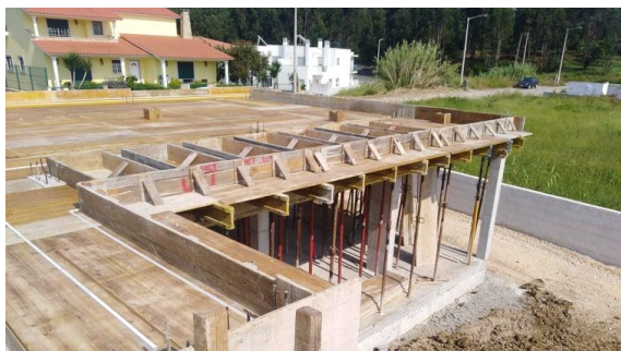
Figura 59 - Pormenores construtivos (31 de maio de 2020). Fonte: Autor.
