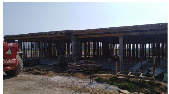
Figura 57 - Fachada principal da moradia (31 de maio de 2020). Fonte: Autor.
