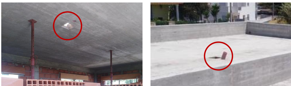
Figura 18 - Localização da zona de saída de fumos do recuperador de calor. Fonte: Autor.
