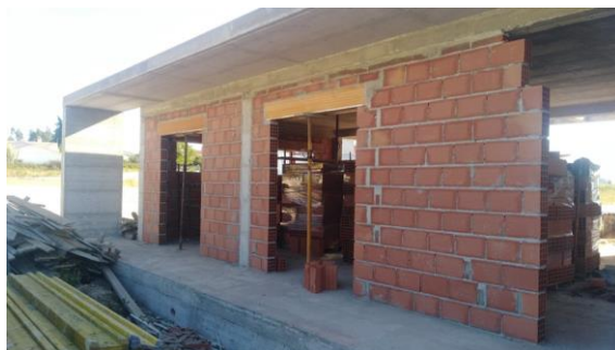
Figura 65 - Fachada principal (4 de julho de 2020). Fonte: Autor.
