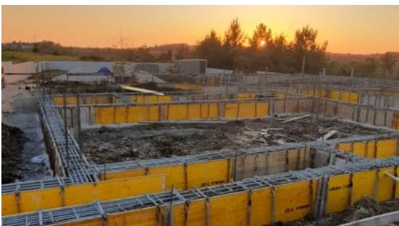
Figura 56 - Pormenores construtivos (28 de maio de 2020). Fonte: Autor.
