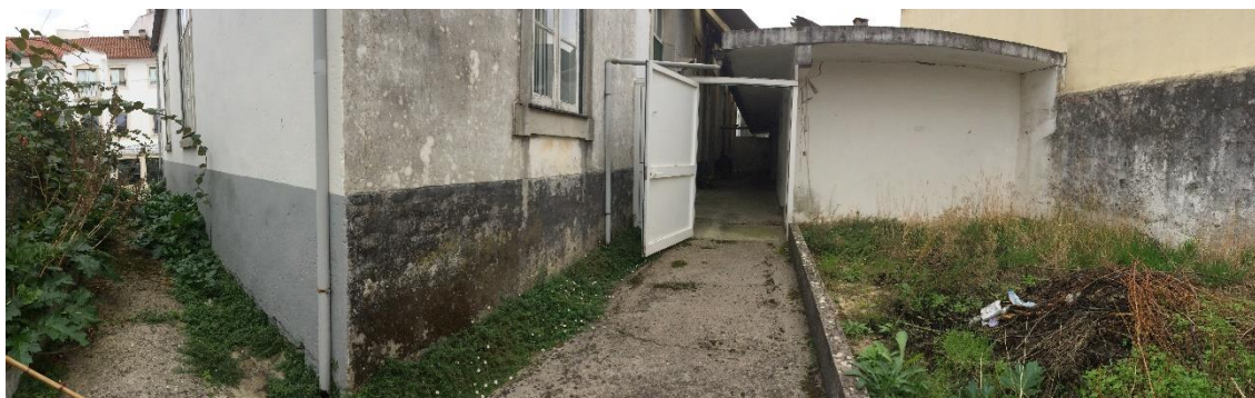
Figura 7_ Vista do interior para a entrada a norte e da parte separatória das duas estruturas
