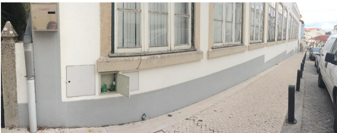
Figura 14_ Pormenor da fachada principal, evidenciando as cantarias
