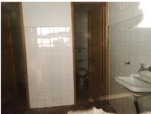
Figura 12_ Exemplo de instalação sanitária existente
