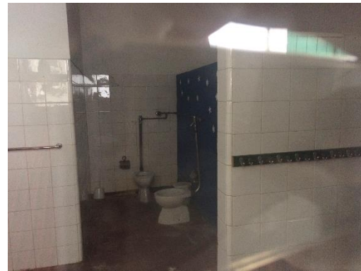
Figura 13_ Exemplo de instalação sanitária existente
