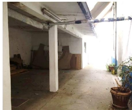
Figura 5_ Corredor separatório das estruturas
