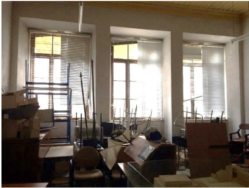
Figura 9_ Pormenor de vãos no interior
