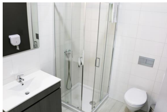
Figura 38_ Instalações sanitárias quartos de casal
