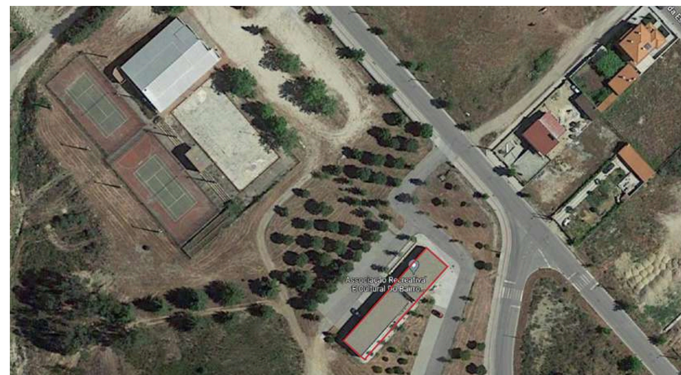
Figura 2- Localização do Edifício
