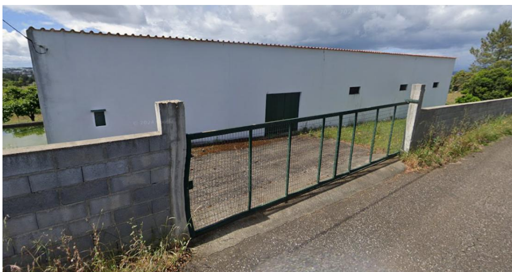
Figura 6. Alçado frontal do barracão, Google Maps, Street View (2024)
