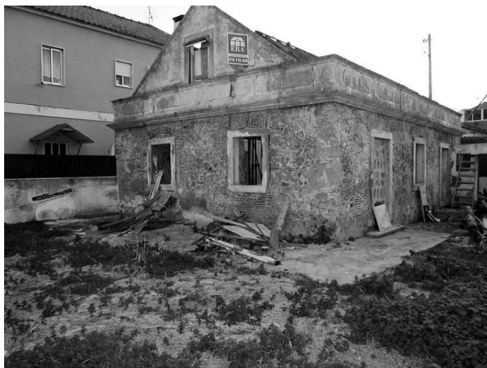
Figura 35. Edifício existente, Fachada principal, Casa Pescadores, ArchDaily (2017).
