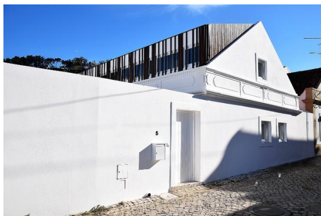
Figura 37. Fachada atual após reabilitação, Inês Brandão, ArchDaily (2017).
