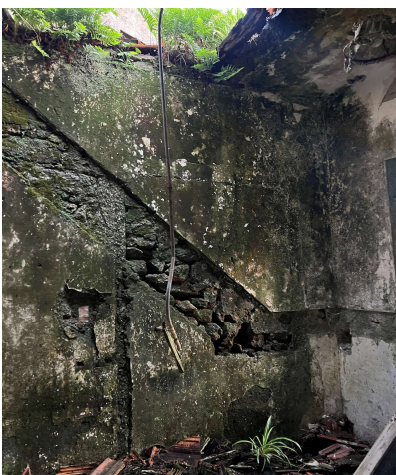
Figura 15- Escadas a Oeste. Pereira (2026).
