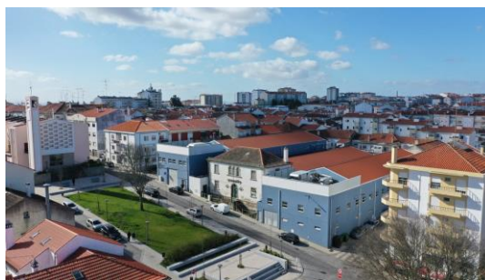
Figura 2 - Instalações da Fábrica da Criatividade.
