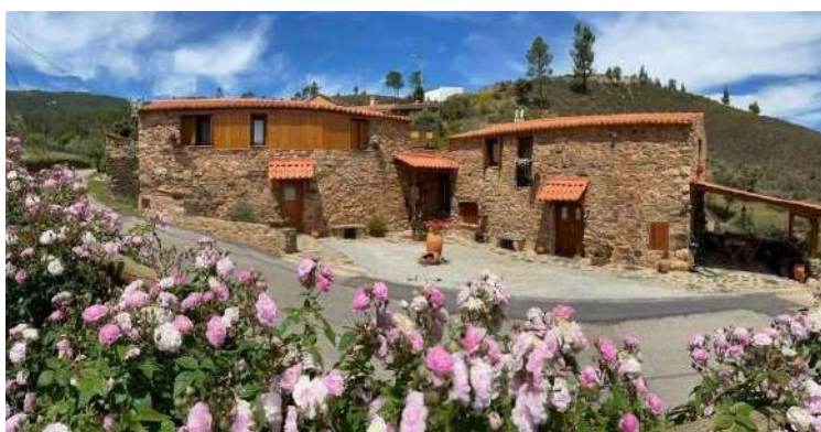
Figura 36 - Fachada Lateral Biblioteca e Lounge. Fonte: Refúgio do Raposo
