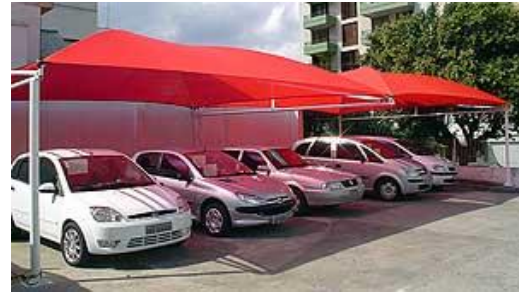
Figura 20 , cobertura de parque de estacionamento
