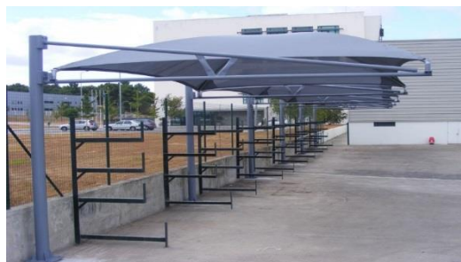
Figura 21 , cobertura em tela tencionada num parque de estacionamento
