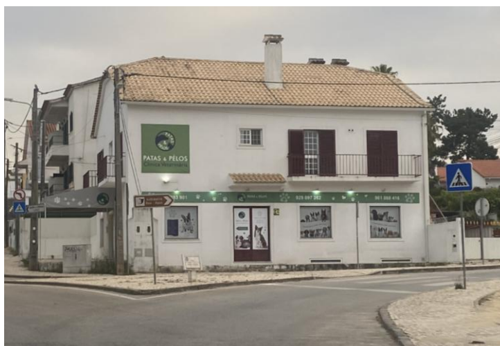
Figura 1- Exterior do Edifício da CVPP
