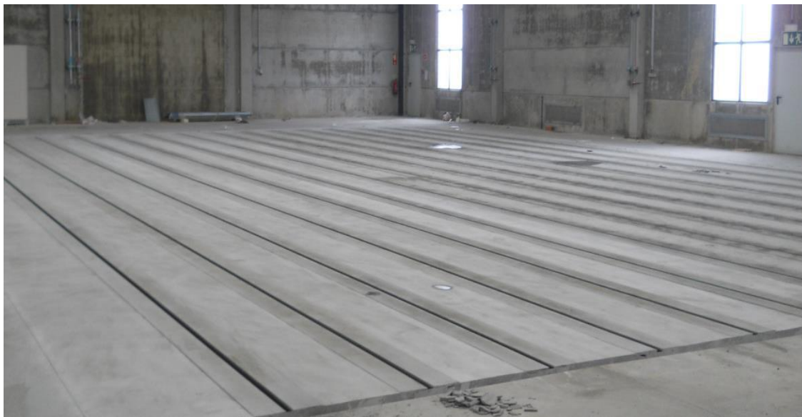
Figura 3.4 – Piso estruturado 24m x 14m, Fonte: ISQ
