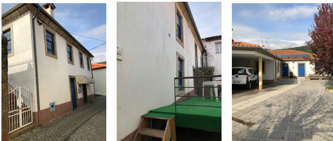
Figura 12. Exterior do edifício a intervir.
