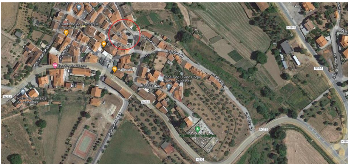
Figura 5. Enquadramento do edifício na Aldeia. Fonte: GoogleMaps
