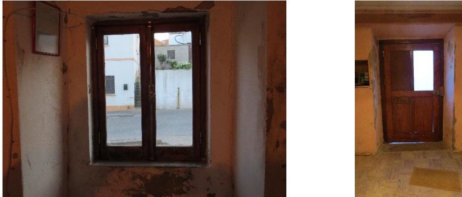
Figura 11 - Caixilhos e portas em madeira.
