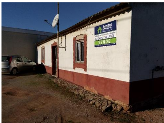
Figura 1 - Fachada Principal. Fonte: Patrícia Caldas.
