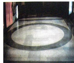
Figura-9: Pavimento em mármore da entrada
