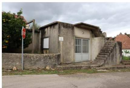
Figura 8-1ª Edificação, alçado norte. Fonte: Gil, P.(27 de outubro de 2024)
