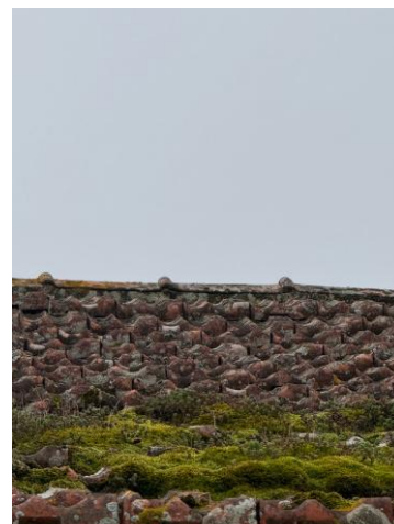
Figura 107-2ª Edificação, Vegetação indesejada no telhado. Fonte: Gil, P. (27 de outubro de 2024).
