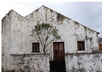
Figura 15- 2ª Edificação, alçado norte. Fonte: Gil,P. (27 de outubro 2024)
