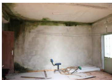
Figura 12- Zona de sala que dá acesso ao exterior. Fonte: Gil, P. (27 de outubro)
