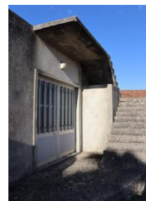
Figura 10-1ª Edificação, pormenor. Fonte: Gil,P. (27 de outubro de 2024).
