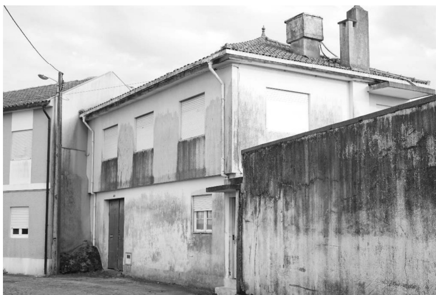
Figura 3 – Espaço a intervencionar, exterior. Fonte: Autor.
