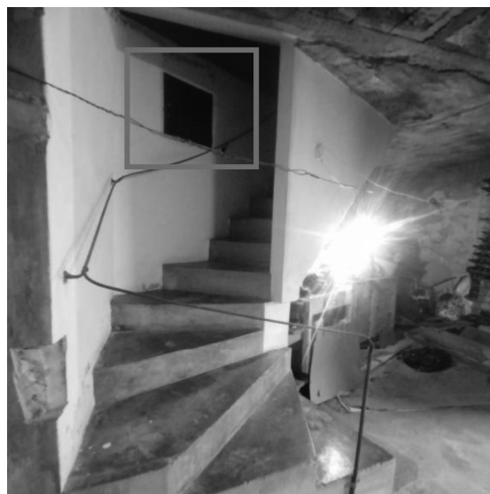
Figura 38 – Quadro Elétrico. Fonte: Autor.
