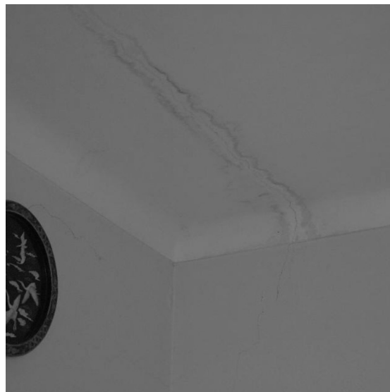
Figura 36 – Passagem de tubo com água. Fonte: Autor.
