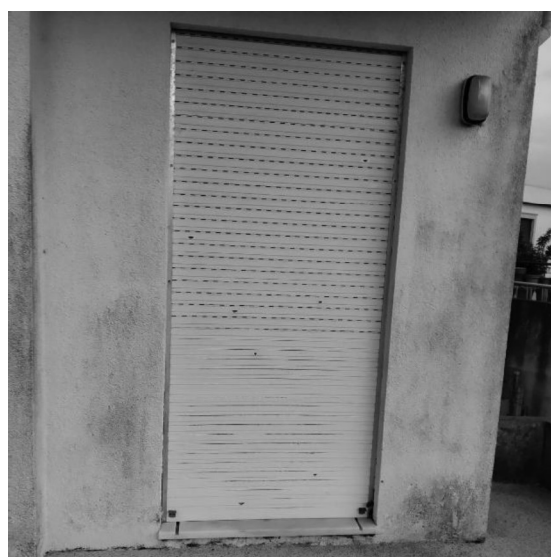
Figura 15 – Entrada Exterior Piso 1. Fonte: Autor.
