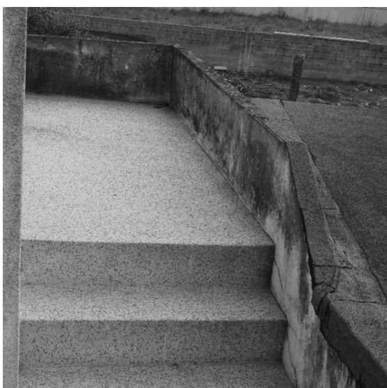
Figura 14 – Escadas Exteriores. Fonte: Autor.
