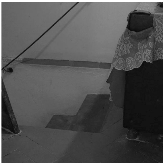
Figura 24 – Escada interiores Piso 1. Fonte: Autor.
