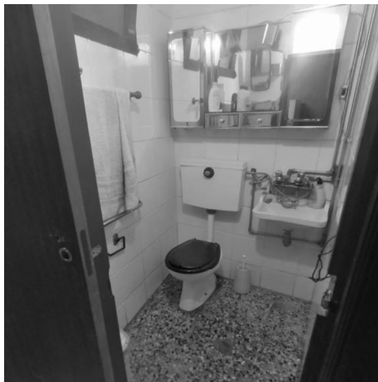
Figura 9 – Instalação Sanitária Piso 0. Fonte: Autor.
