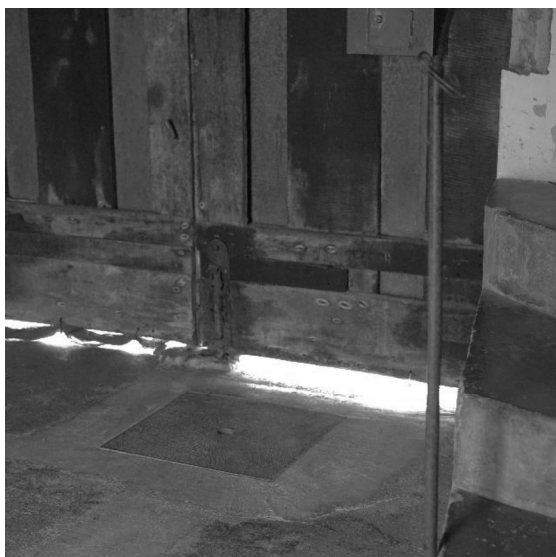
Figura 37 – Caixa de Visita. Fonte: Autor.
