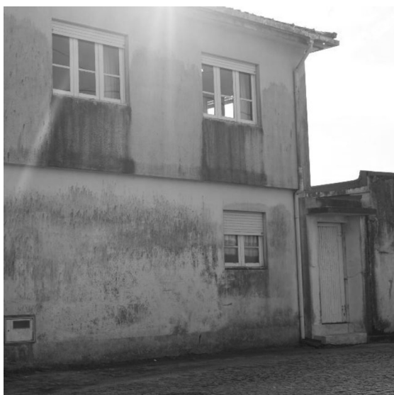
Figura 4 – Alçado Principal. Fonte: Autor.
