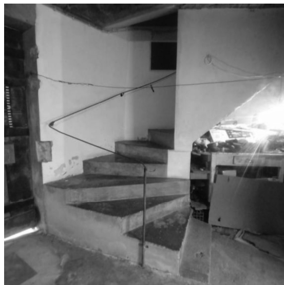
Figura 25 – Escada interiores Piso 0. Fonte: Autor.
