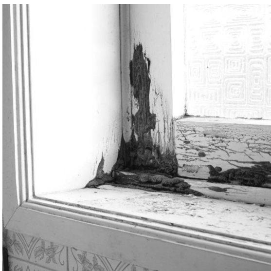
Figura 35 – Janela Instalação Sanitária. Fonte: Autor.
