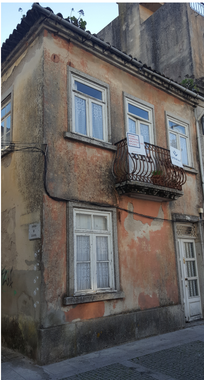
Figura 1 – Alçado Principal. Fonte: Gabinete de Arquitetura
