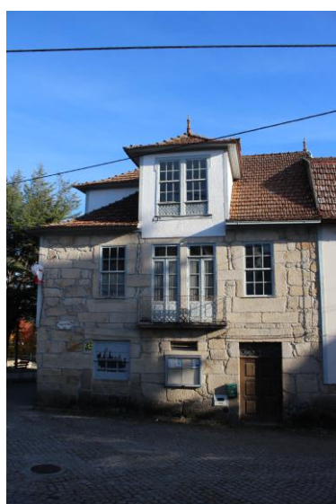
Figura 11 — Fachada Principal Oeste; ano 2021; Fonte: Ana Ferreira
