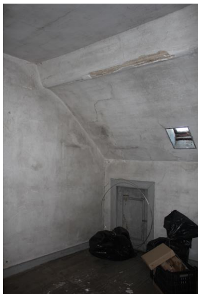
Figura 38 – Sala 6, situada na fachada Oeste; ano 2021; Fonte: Ana Ferreira
