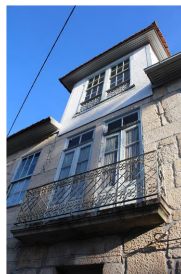
Figura 13 — Janelas dos pisos superiores; ano 2021; Fonte: Ana Ferreira
