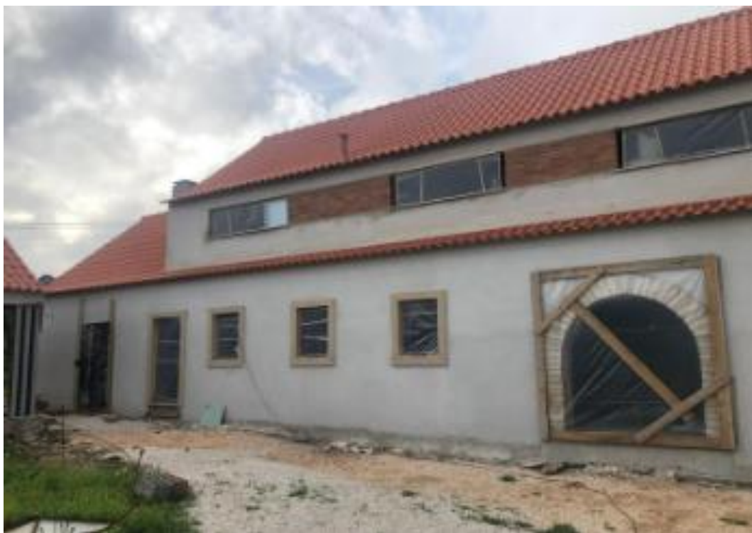
Figura 4 - Fotografia da moradia rehabilitada, 2023 Fonte: Jacinta Vaz, 2023
