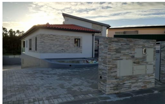
Figura 4 - Fotografia do Exterior
