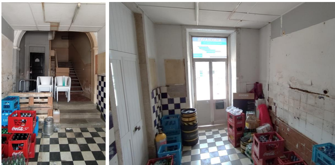
Figura 8 - Hall de entrada do prédio. Fonte: Cristiana Lourinho, 2022.
