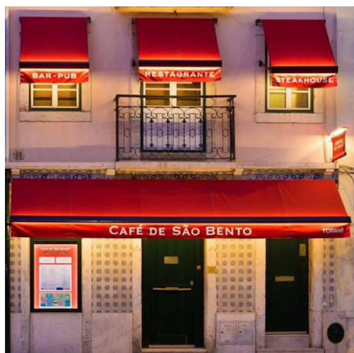
Figura 3 - Fachada. Fonte: Autor
