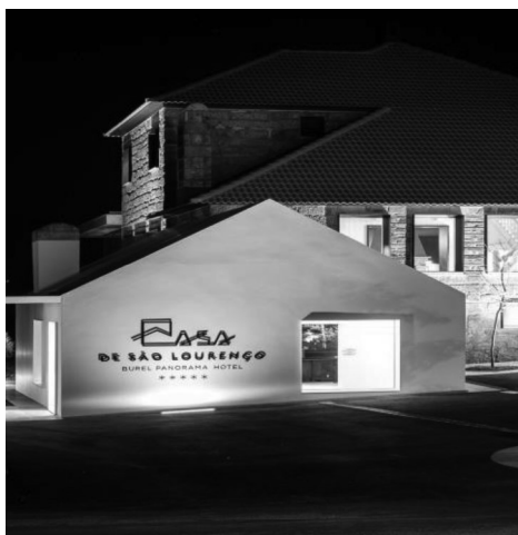
Figura 24 - Casa de São Lourenço, Fachada Reabilitada; Fonte: Casa de São Lourenço, Data: 22 de março de 2025
