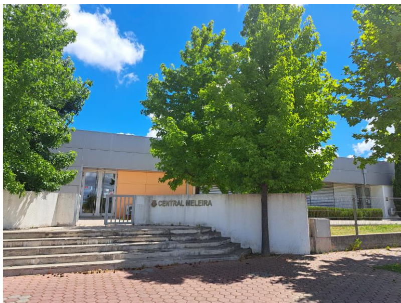
Figura 1 - Edifício da Associação Meltagus
