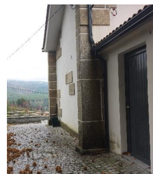
FIG.4 – Lateral do edifício
