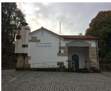
FIG.2 – Fachada do edifício
