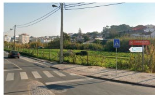
Sinalização junto à rotunda
